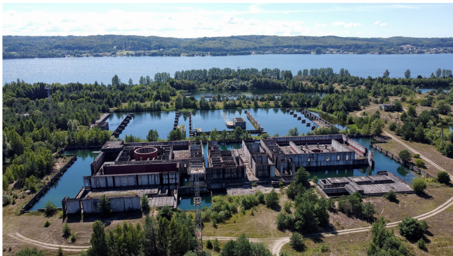
Nieukończony główny budynek elektrowni jądrowej „Żarnowiec”. Źródło: Wikipedia.org, Mzywiał, CC BY-SA 4.0.
