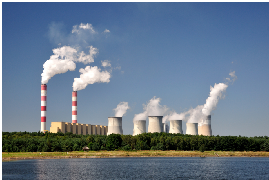
Elektrownia węglowa w Bełchatowie. Źródło: Adobe Stock.
